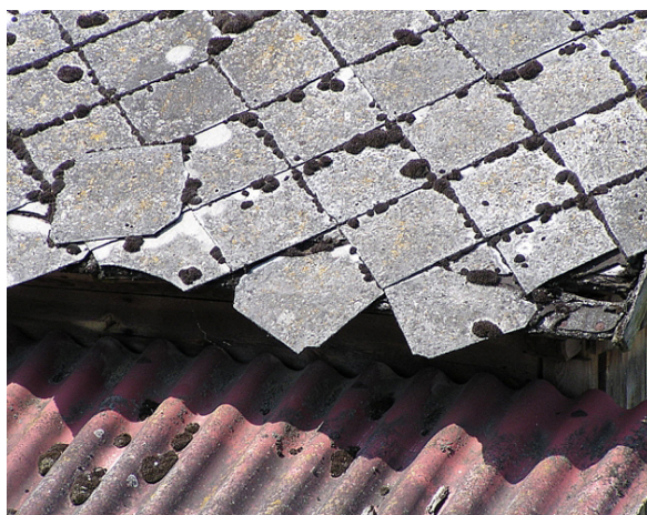
Rys. 8. Pokrycie dachowe ocenione w I stopniu pilności.
