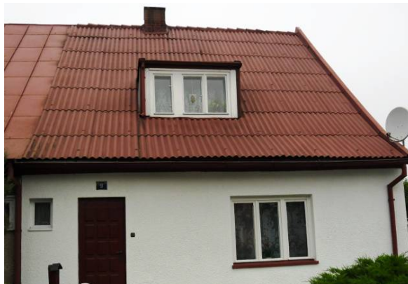
Rys. 6. Pokrycie dachowe ocenione w III stopniu pilności.
